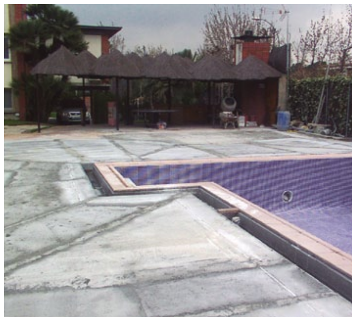
Terraza con las pendientes terminadas antes de colocar las baldosas
