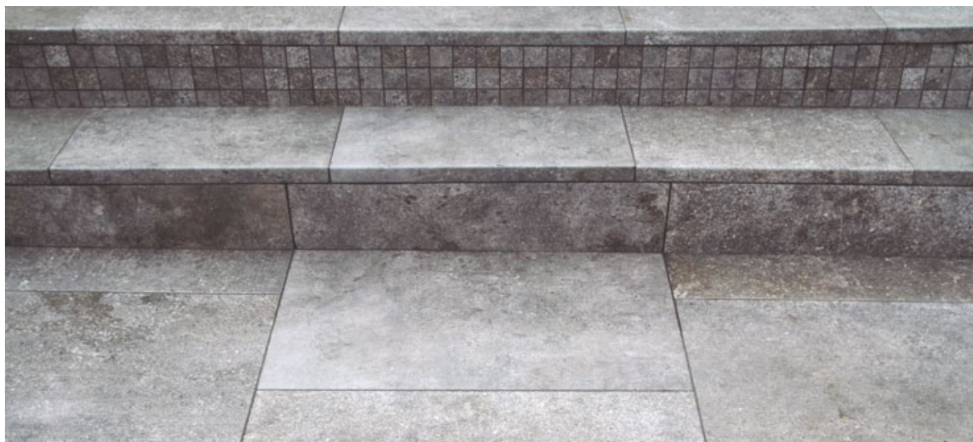
Terraza realizada con Mystery Blue Stone 48,8x79,2 donde se aprecia la pendiente hacia la derecha.
