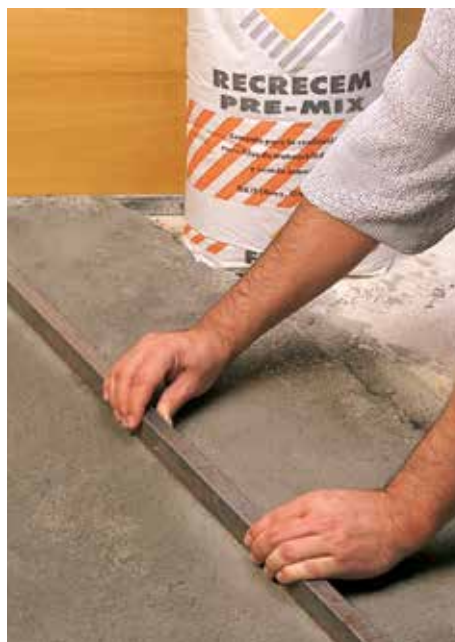
Aplicando el mortero de recrecido RECRECEM PRE-MIX
