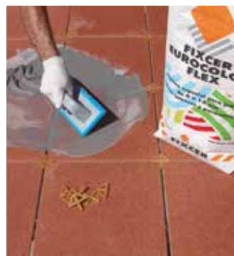
EUROCOLOR FLEX se adapta a juntas de colocación de 0 a 16 mm
