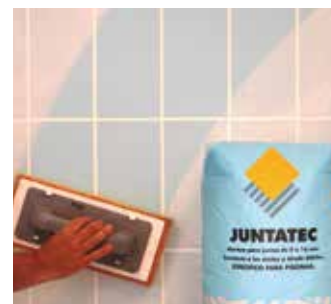
Rejuntado con el mortero de juntas especial para piscinas JUNTATEC
