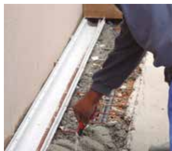
Colocación del mortero alrededor de la canaleta
