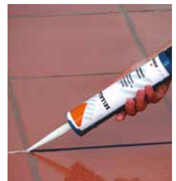
Rellenado de las juntas de dilatación con SELLALASTIC
