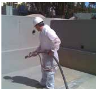
Aplicación del HIDROELASTIC con pistola de proyección
