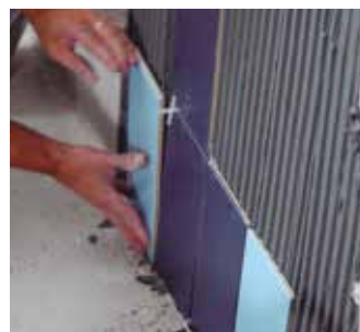
Colocación de las losetas con TECNOCOL FLEX
