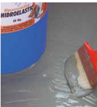
Aplicación de la impermeabilización HIDROELASTIC
