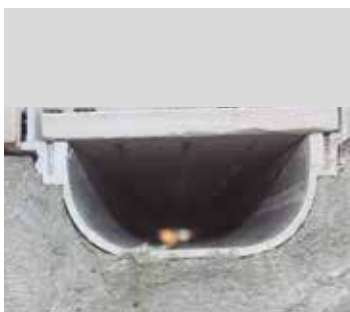
Detalle de la canaleta embebida en mortero
