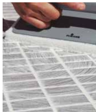
Primera limpieza con la llana para limpiar de estropajo blando
