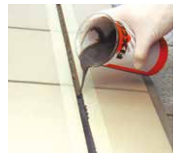
Vertido del SELLAFIX para sellar la junta de dilatación
