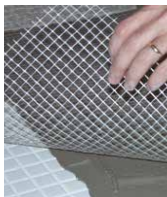
Colocación de la malla NET-MORTER-110
