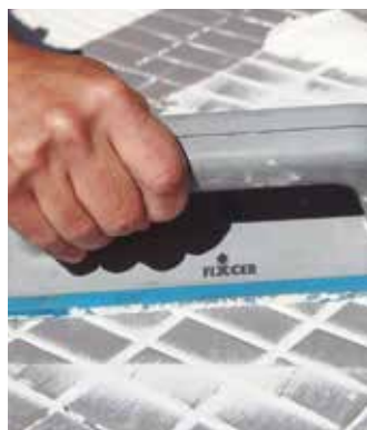
Rejuntado del mosaico con el mismo FIXSET FLEX
