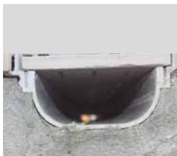
Détail de la goulotte intégrée dans le mortier
