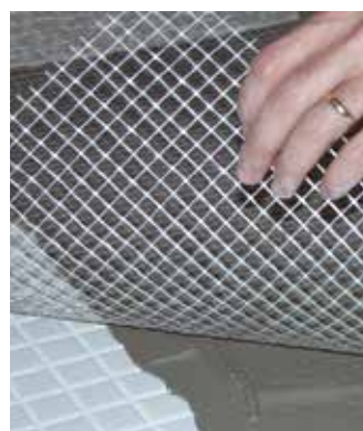
Installation de la maille NET-MORTER-110
