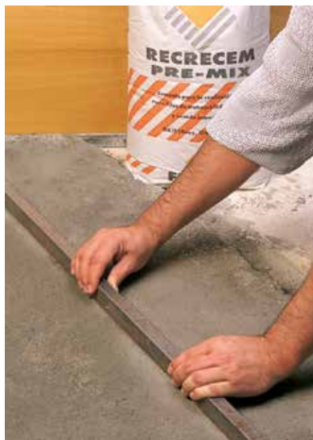
Appliquer le mortier de surélévation RECRECEM PRE-MIX
