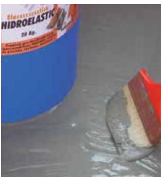
Application de l'imperméabilisation HIDROELASTIC
