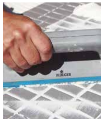
Jointoiment de la mosaïque avec le FIXSET FLEX
