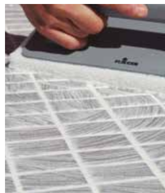
Premier nettoyage à la truelle à éponge souple
