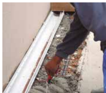
Installation du mortier autour de la goulotte
