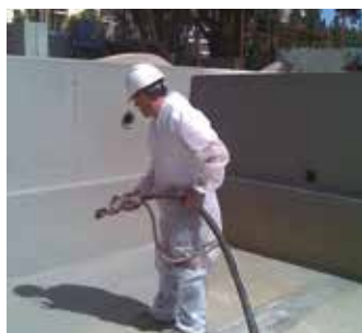
Application de l' HIDROELASTIC à l'aide d'un pistolet de projection
