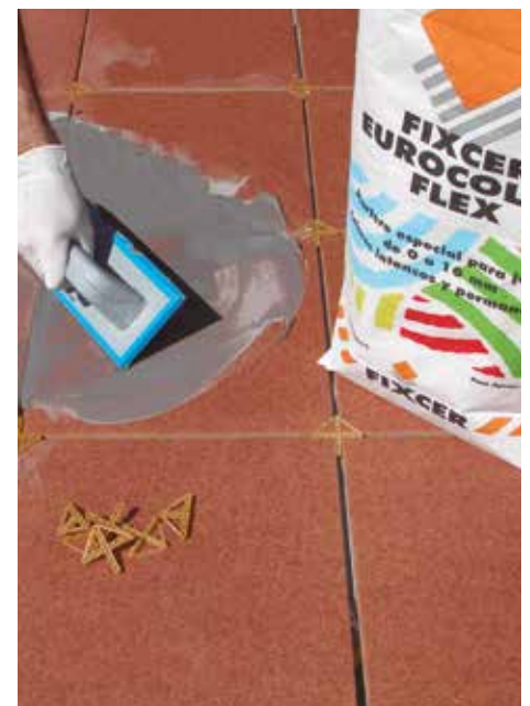
Remplir les joints d'union avec EUROCOLOR FLEX
