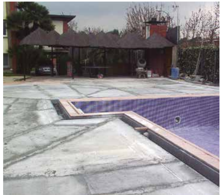
Terrasse avec pentes terminées avant de placer les dalles
