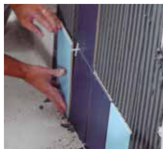
Installation des carreaux à l'aide de TECNOCOL FLEX
