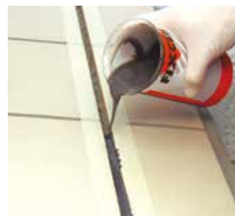
Versement du SELLAFIX pour sceller le joint de dilatation
