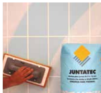
Jointoiment à l'aide du mortier pour joint spécial pour piscines JUNTATEC
