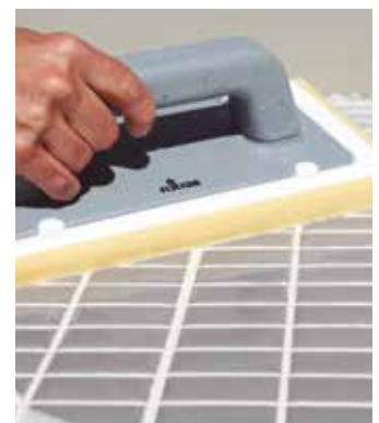
Nettoyage final à l'éponge
