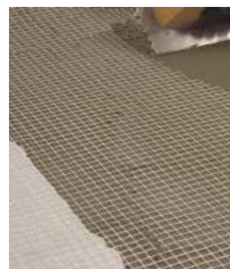
Recouvrir la maille avec du FIXMAX S2
