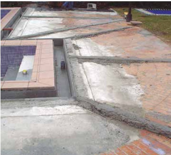
Réalisation de pièces maîtresses pour faire les pentes
