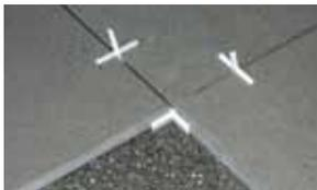
**05** Utilizaremos crucetas NO recuperables de 2 mm. Las crucetas sirven tanto para homogeneizar el ancho de la junta como para el trabado de las piezas. Quedarán colocadas permanentemente.
