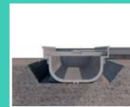
**2** NIVELACIÓN DE LOS CANALES SOBRE LA BASE Y COLOCACIÓN DE LOS SOPORTES.
