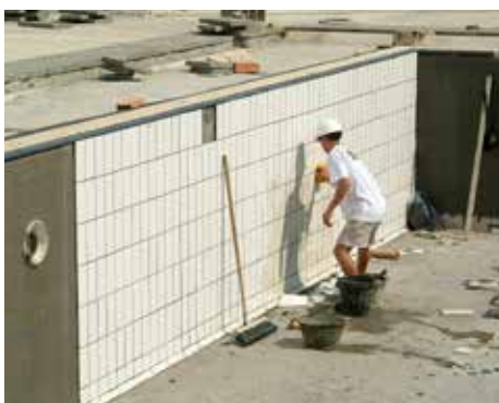
POSE DES CARREAUX
