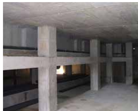
ACCÈS POSSIBLE SOUS LE BASSIN
