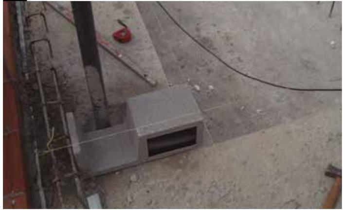
Para simplificar el proceso de hormigonado, éste se puede realizar en dos tiempos. Primero se deja una zona de recepción plana con unas esperas de hierro y colocamos una junta hidroexpansiva tipo **FUGA STOP MINI** en el medio de las esperas. Posteriormente terminaremos por rellenar el talón (después del paso 5).
