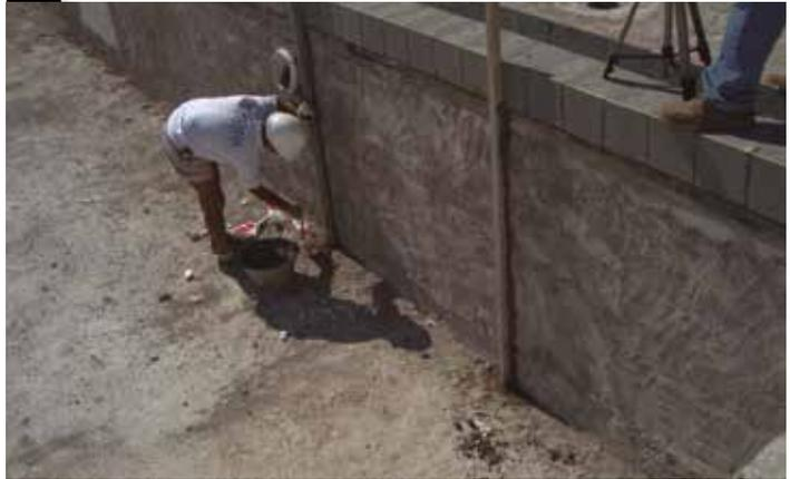
Usando los bloques como guía, realizamos el recocado de mortero de las paredes con un mortero de calidad constante y de secado rápido tipo **FIX-REVOCO**.
