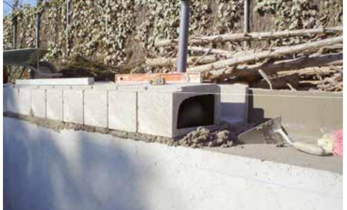
Se colocan los bloques de hormigón con mortero aditivado con un látex tipo **PRIMFIX** a razón de 1 parte de **PRIMFIX** por 2 partes de agua.
