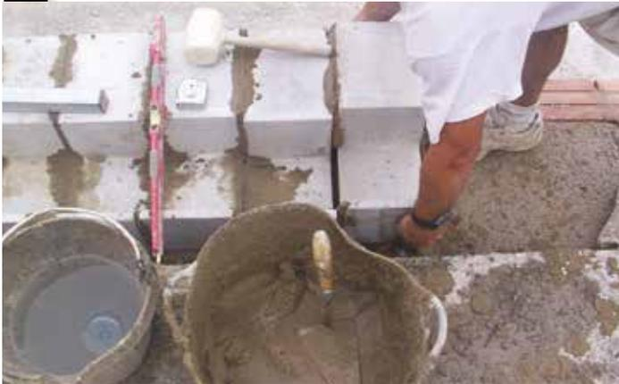
Es imprescindible poner mortero también en la junta entre los bloques. Una vez colocados los bloques rellenamos el talón posterior con hormigón.
