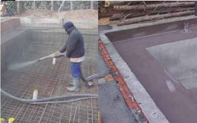
Se proyecta el hormigón formando las paredes, fondo de vaso y murete perimetral, teniendo en cuenta que hay que dejar una zona de recepción del bloque S9 que se ajuste a las medidas del mismo.
