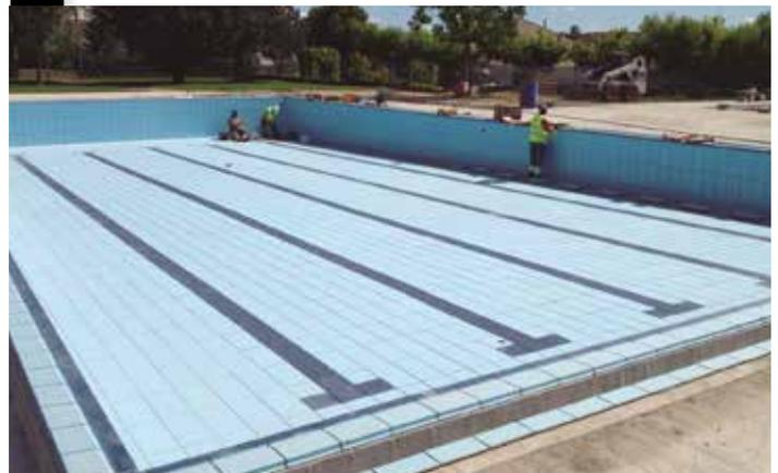
**Colocación de la cerámica:** usamos el cemento cola de clase C2 T S1 especial para pegar gres porcelánico encima de la impermeabilización tipo **TECNOCOL FLEX**.
