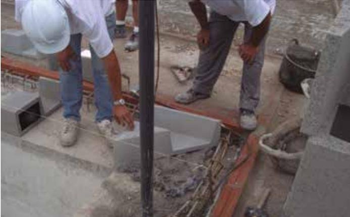
Empezamos colocando las piezas de las esquinas con un nivel láser. Colocamos cordeles entre ellas. A continuación colocamos los bloques S9 entre esquina y esquina.
