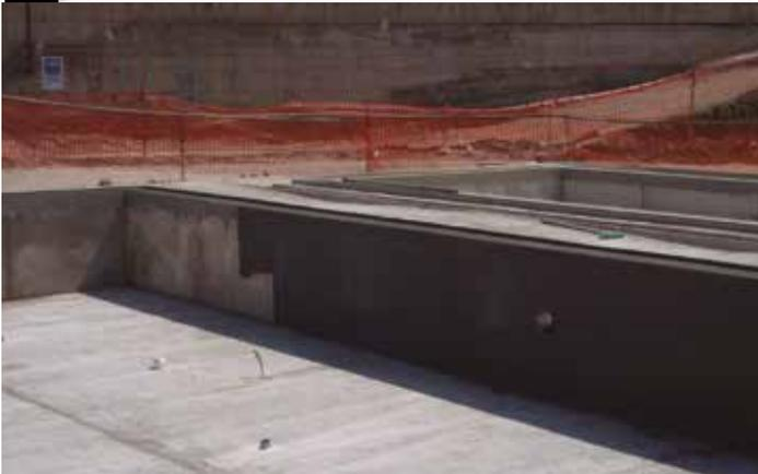
Realizamos la impermeabilización del vaso con un impermeabilizante elástico tipo **HIDROELASTIC** donde vaya a ir baldosa encima. Y la impermeabilización de la canal con un impermeabilizante tipo **HIDROFIX**.
