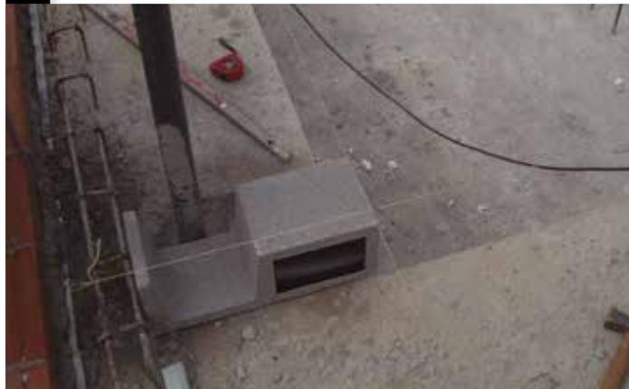
Pour simplifier le processus de bétonnage, il est possible de le réaliser en deux temps. Tout d'abord, il faut laisser libre une surface de réception plate équipée de fers d'attente et installer un joint hydro-expansif de type **FUGA STOP MINI** au milieu des fers d'attente. Nous terminerons ensuite cette tâche en remplissant le talon (après l'étape 5).
