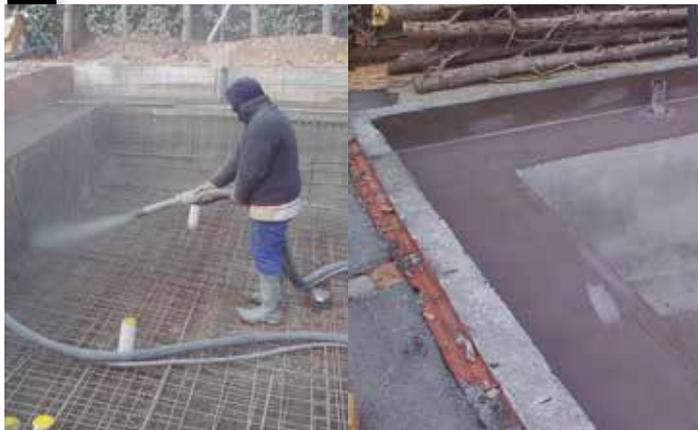
Le béton est projeté en formant les parois, le fond du bassin et le mur périmétrique, en tenant compte de la zone de réception du bloc S9, adaptée aux dimensions de ce dernier.
