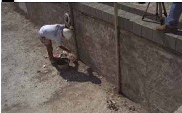
En utilisant les blocs comme repères, nous procédons à la surélévation du mortier dans les murs à l'aide d'un mortier de qualité constante et à prise rapide de type **FIX REVOCO**.
