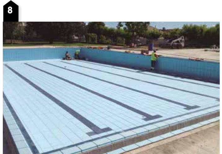
Nous effectuons le processus d'imperméabilisation du bassin en appliquant un imperméabilisant élastique de type **HIDROELASTIC** à l'endroit où seront posées les dalles. Nous effectuons également l'imperméabilisation de la gouttière au moyen d'un imperméabilisant de type **HIDROFIX**.
