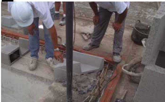
Nous commençons par installer les pièces des coins à l'aide d'un niveau laser. Nous installons des ficelles entre les coins. Ensuite, nous installons les blocs S9 entre les coins.
