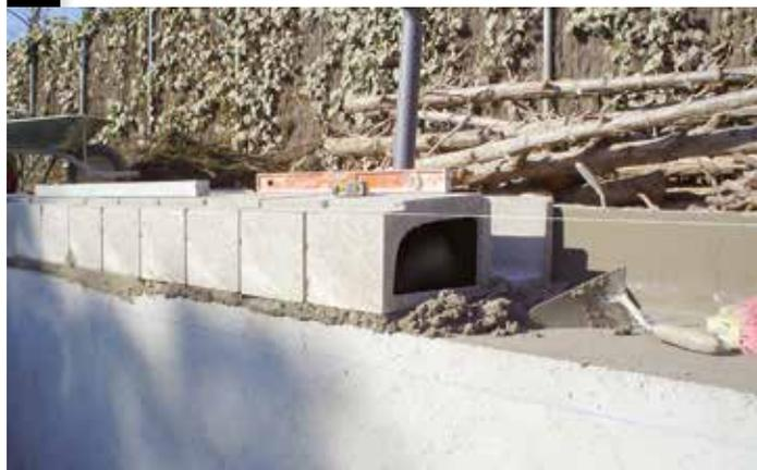
Il faut installer les blocs de béton à l'aide de mortier enrichi en latex de type **PRIMFIX** à raison d'1 mesure de **PRIMFIX** pour 2 mesures d'eau.
