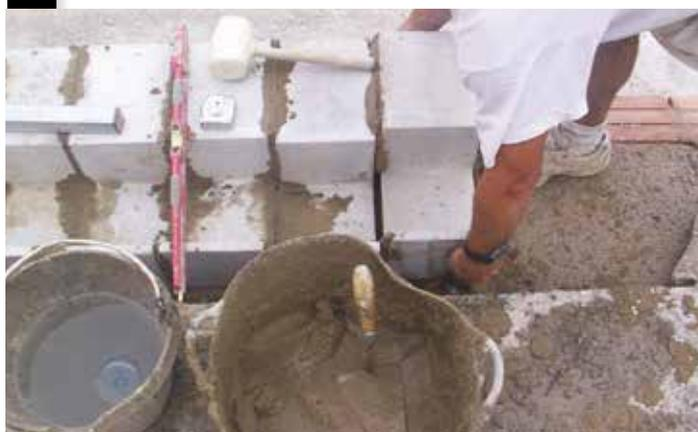
Il est indispensable de mettre également du mortier dans le joint se situant entre les blocs. Une fois les blocs installés, nous remplissons le talon arrière avec du béton.
