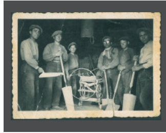
—1935— Se instala la electricidad en el Taller. Primer molino: elaboración mecánica de ladrillos.
