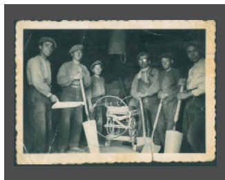
—1935— L'Atelier se dote de l'électricité. Premier broyeur : fabrication mécanique de briques.
